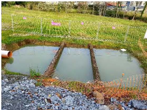
Foto nº2: Balsa decantación Etxebarria
