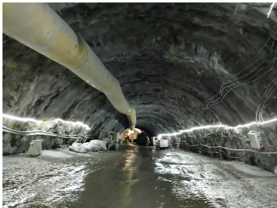
Foto nº1: Excavación de túnel en la boca oeste
