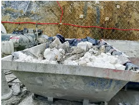
Foto nº6: Limpieza de canaletas en S4
