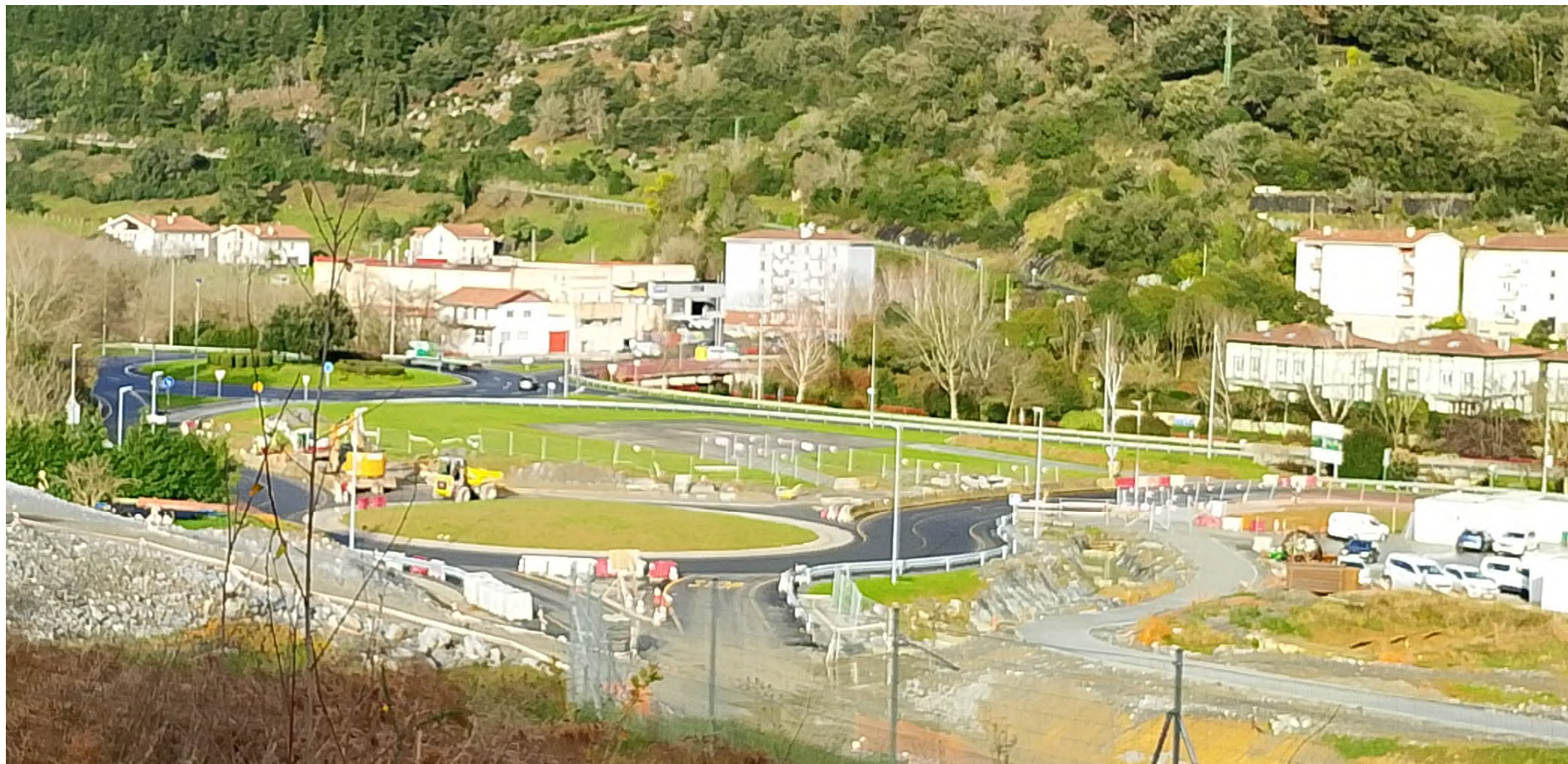
EJE 2 Y ZONA HELIPUERTO
