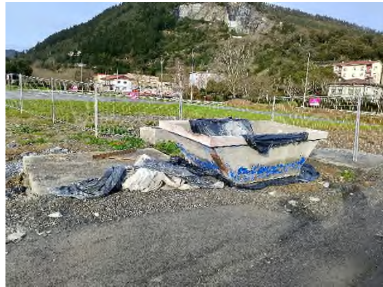
Foto nº7: Limpieza de canaletas en Markina eje-2
