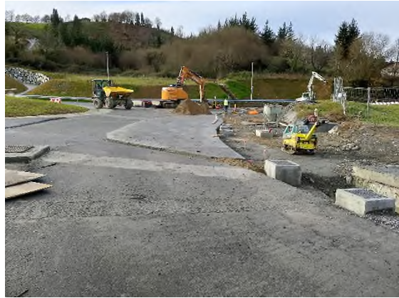
Foto nº8: Eje 2 y acceso helipuerto
