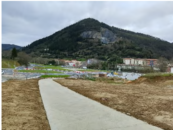
Foto nº3: Extendido de tierra vegetal en Eje-19.
