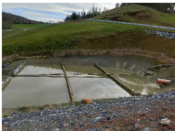
Foto nº24: Balsa de decantación del DS
