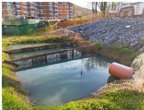
Foto nº20: Balsa de decantación Atain
