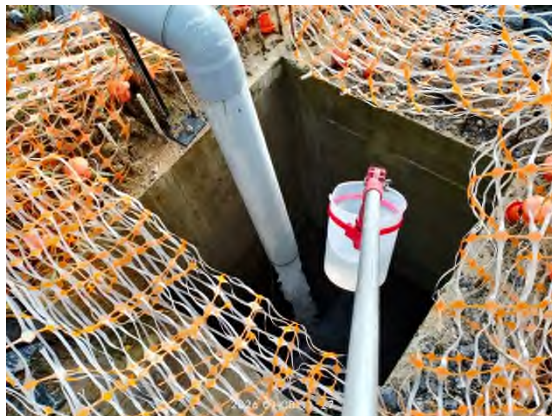
Foto nº16: Vertido de la depuradora
