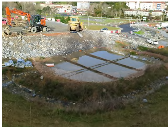
Foto nº3: Balsa de decantación del DS
