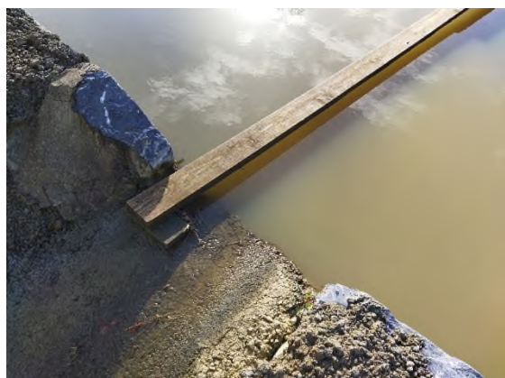
Foto nº17: Zona de vertido de la balsa del DS
