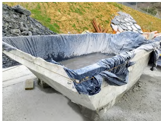
Foto nº9: Limpieza de canaletas en S-4
