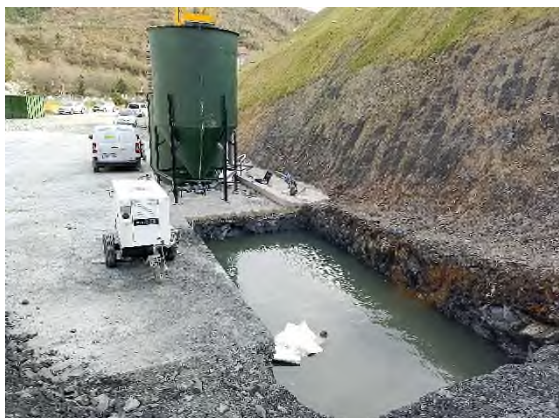
Foto nº14: Instalación de planta depuradora.
