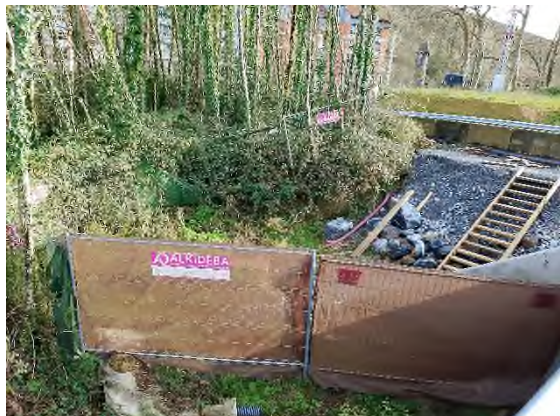
Foto nº22: Detalle vallado opaco acondicionado entorno a E-2
