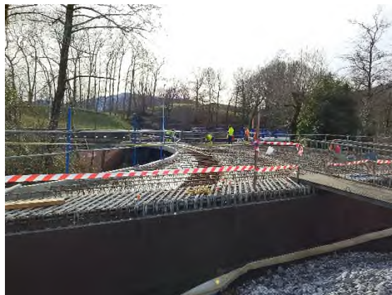
Foto nº6: Estructura 2: conectadores y ferrallado
