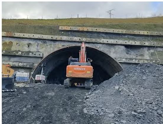
Foto nº2: Excavación de túnel en la boca este
